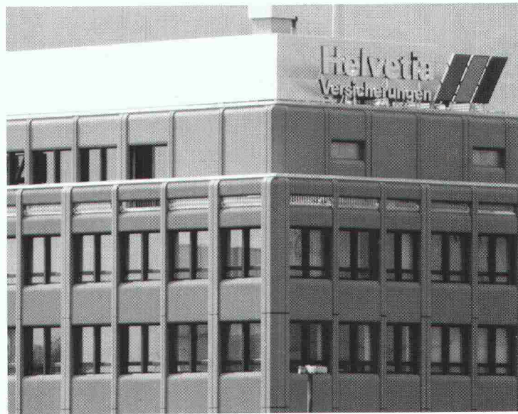
Geschäftshaus Helvetia-Unfall Zürich
