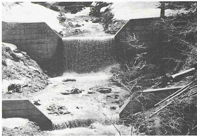
Bild 2. Bodenschutz im Berggebiet (Wildbachverbauung)
