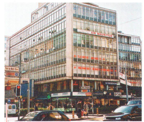
Hauptfassade des 1951-54 entstandenen Mont Blanc-Zentrums von Joseph Saugey. (Bild A. Kern) La façade principale du centre Mont Blanc réalisée de 1951 à 1954 par Joseph Saugey (photo A. Kern)
