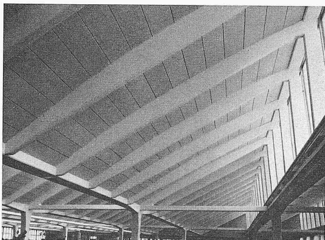
Bild 10. Fertige Halle innen
