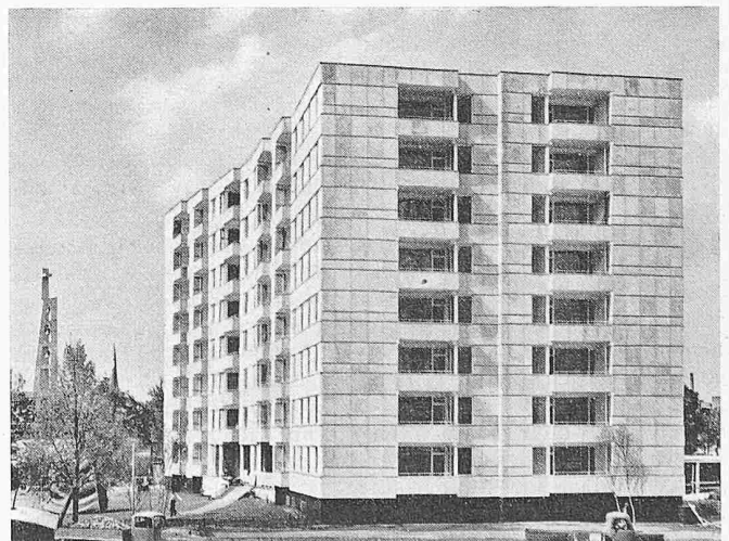
Das fertige Haus von A. Aalto, Seitenansicht
