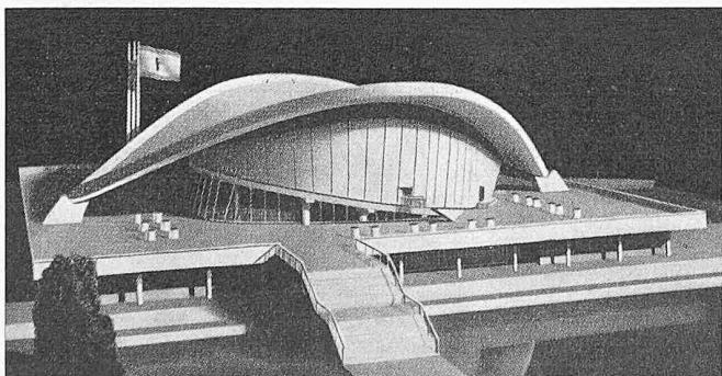
Die im Bau befindliche Kongresshalle von Stubbins, ausserhalb des Ausstellungsgeländes beim Tiergarten
