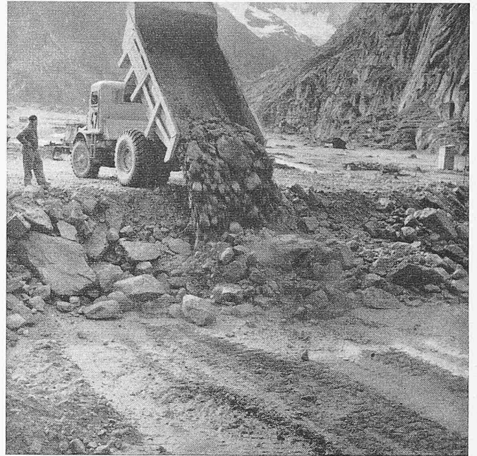
Bild 8. Schüttvorgang beim Einbau nassen Stützkörpermaterials und einer Schütthöhe von 2,0 m (Grossversuch)
