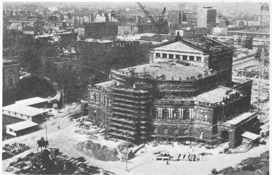
Die Baustelle im Frühjahr 1979. Eindeckungsarbeiten am Dach des Zuschauerraumes, die Bühnenhausbinde während der Rekonstruktion
