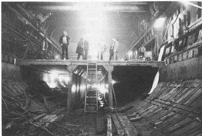
Bild 4. Verwendung von vorfabrizierten Betonteilen beim Tunnelbau
