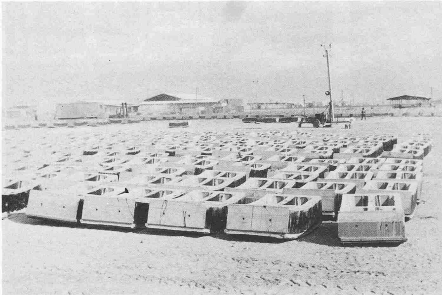
Bild 7. Tübbinglager, im Hintergrund Fabrik für Betonfertigteile
