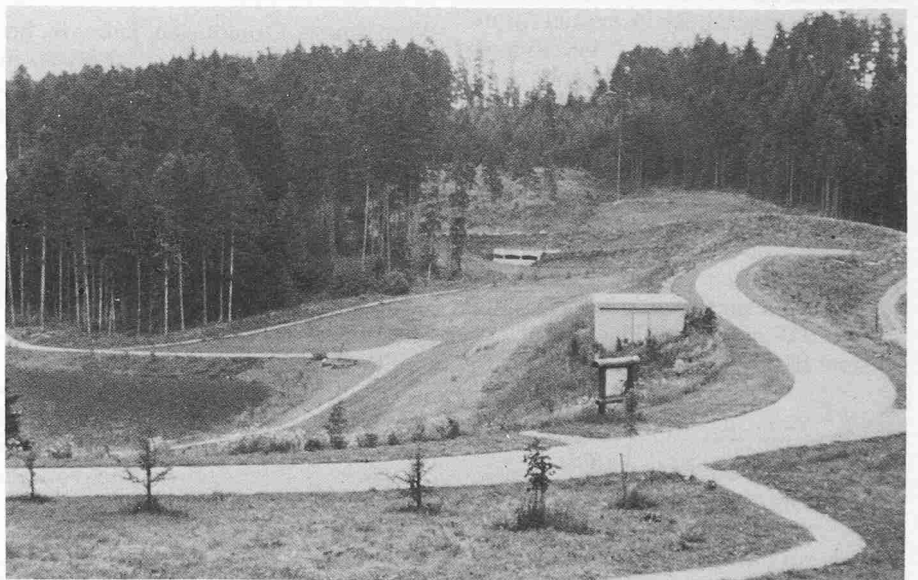
Hochwasserrückhaltebecken Götzenbach. 1,7 Mio m 3 . Kocher-Lein-Verbund.
