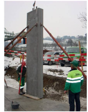
Die fertig versetzte und fixierte Stütze
