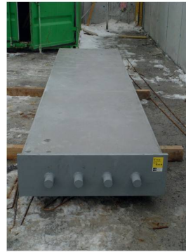
Die ausgelieferte Stütze, zur Montage bereit
