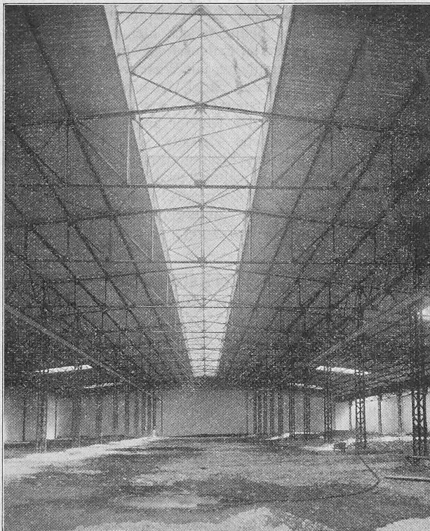
Abb. 6. Ansicht der Halle A vor der Fertigstellung.
