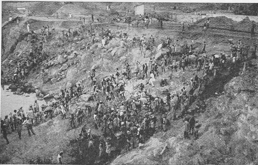
Bild 18. Fundamentausbruch für den Konar I-Damm der Damodartal-Behörde
