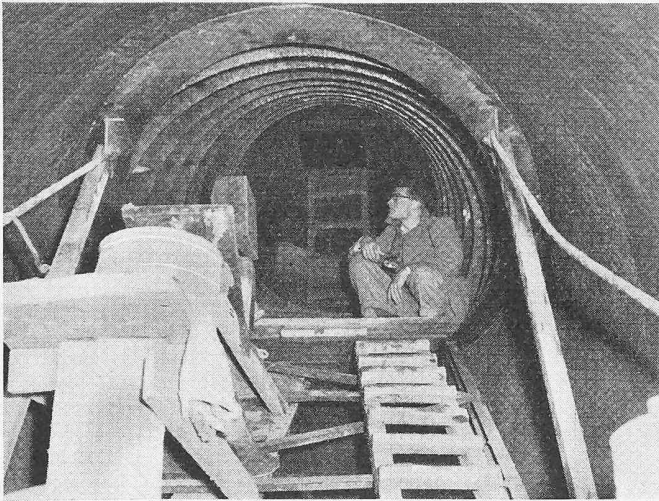
Fig. 8. Coffrage glissant vu par l'arrière
