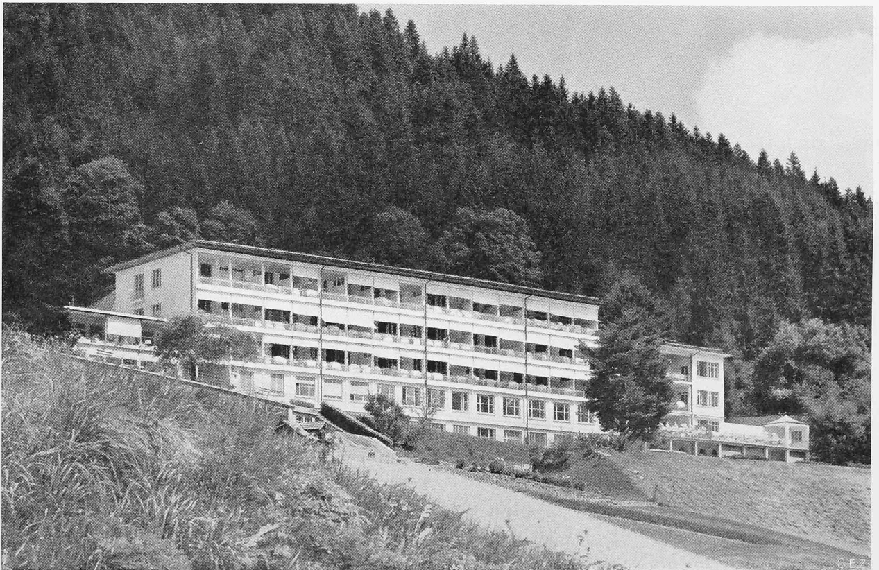
Hauptansicht des Neubaus aus Südsüdwesten
