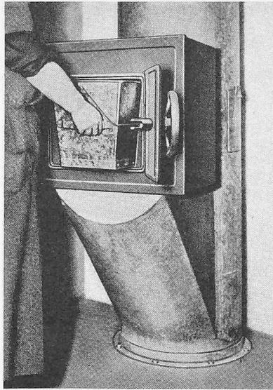
Bild 2. Aufgabestation der ALKETT-Müllschluckanlage (Bauart Dr. Mörs)
