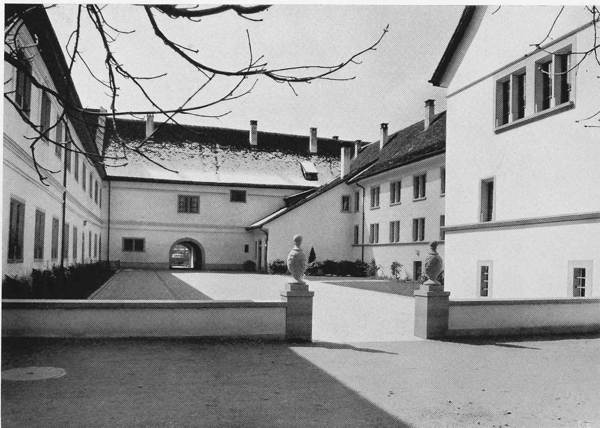
Blick in den Westhof
