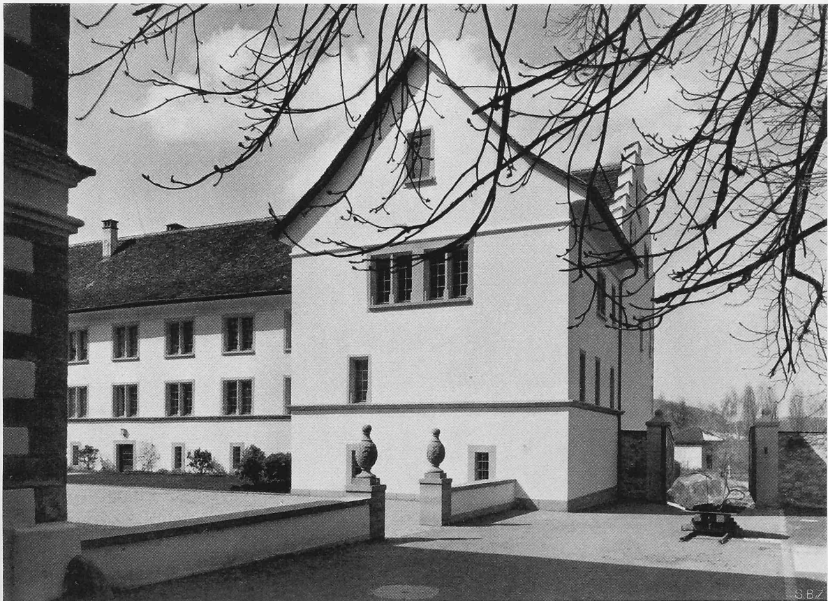
Hofansicht des Westflügels aus Nordosten
