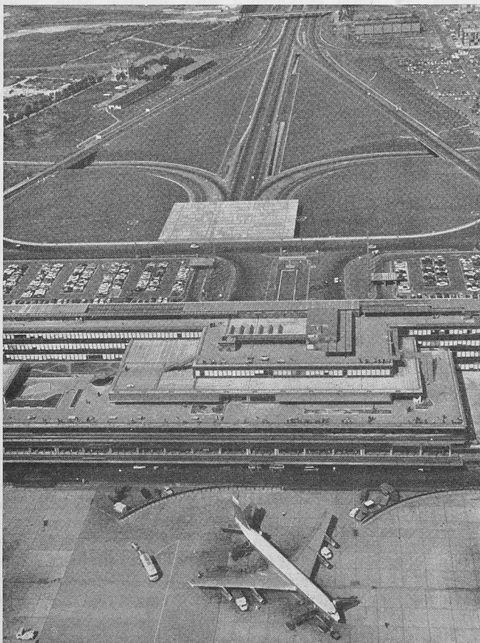
Fliegerbild des Flughafes Orly. Mittelteil des Gebäudes, vorn Standplätze, hinten Parkplätze und Zufahrten. Hinter dem Flugzeug ist die bogenförmig aufgestellte Abschirmwand sichtbar, in der Mitte der oberen Bildhälfte die N 7, welche unter die Bauten taucht
