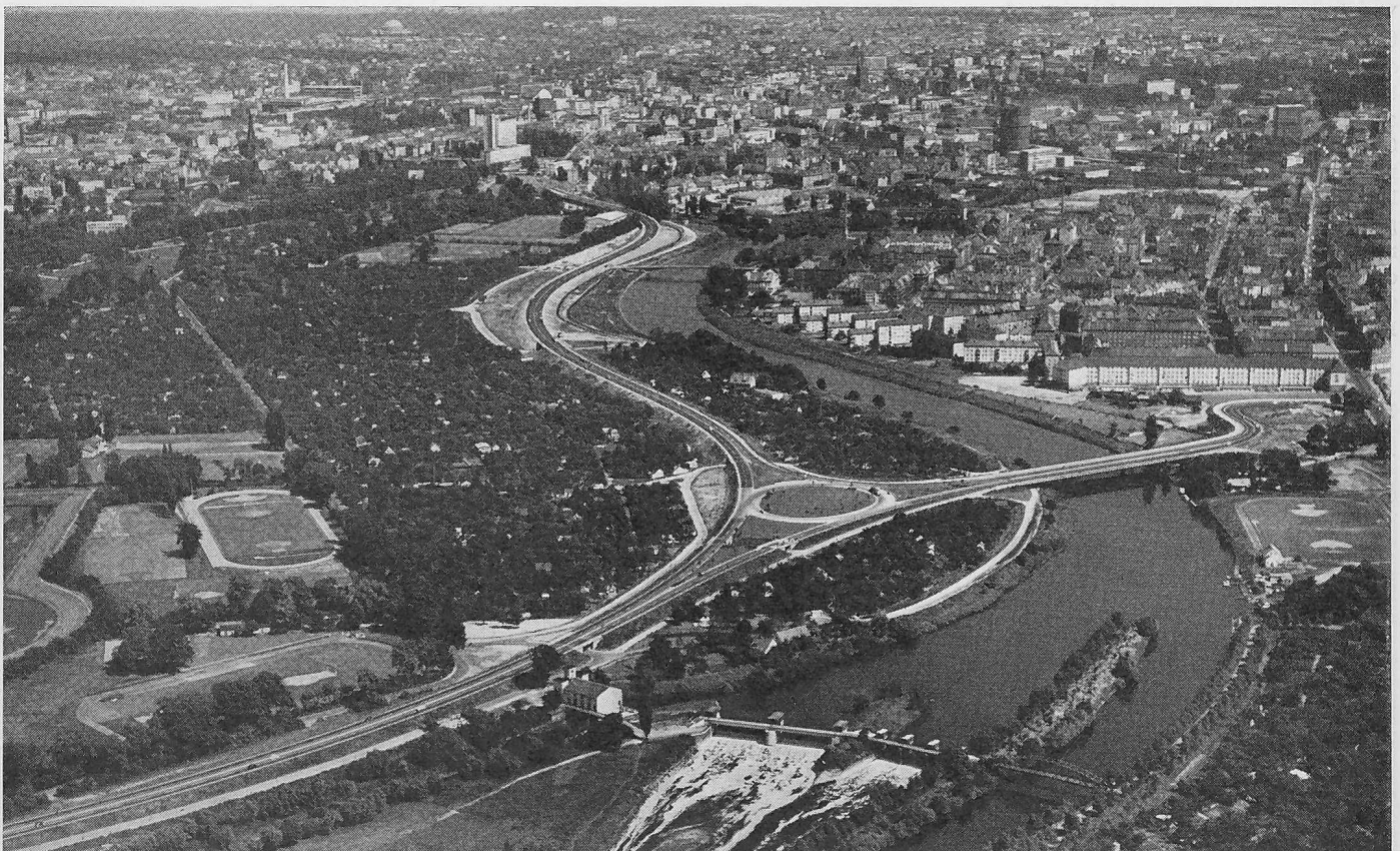
Westschnellweg (im Vordergrund, mit Brücke), welcher der Verlängerung gegen Südosten harret. Blick gegen Osten; der Westzubringer verläuft in Bildmitte gegen den Königswortherplatz (Hochhaus)
