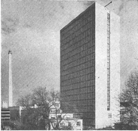
Im Hochbau für hohe Festigkeiten
