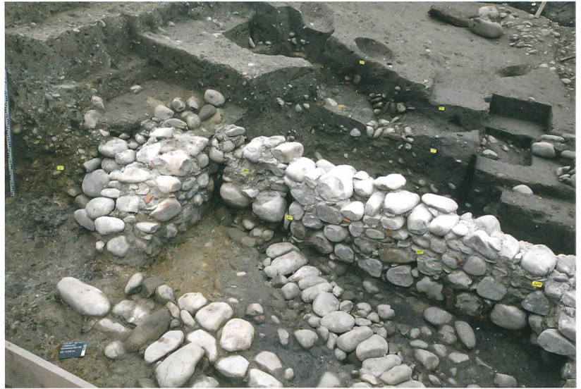
Abb. 8: Langnau, Hinterdorfstrasse 25. Blick auf die Fundamente 4, 80, 79 und 35 (von links nach rechts) des Werkstattgebäudes nach dem Abtragen der Vormauerung 5. Im Vordergrund die Drainagen 18/37 und 57. Blick nach Nordosten.
