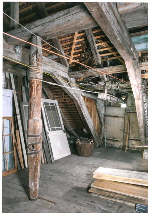
Abb. 3: Ligerz, Chlyne Twann 7. Dachgeschoss. Der Aufzugsgiebel wurde zusammen mit dem Dachstuhl gebaut. Links im Bild ist die originale Winde zu sehen, mit deren Hilfe die Lasten unter Dach befördert werden. Blick nach Südosten.
