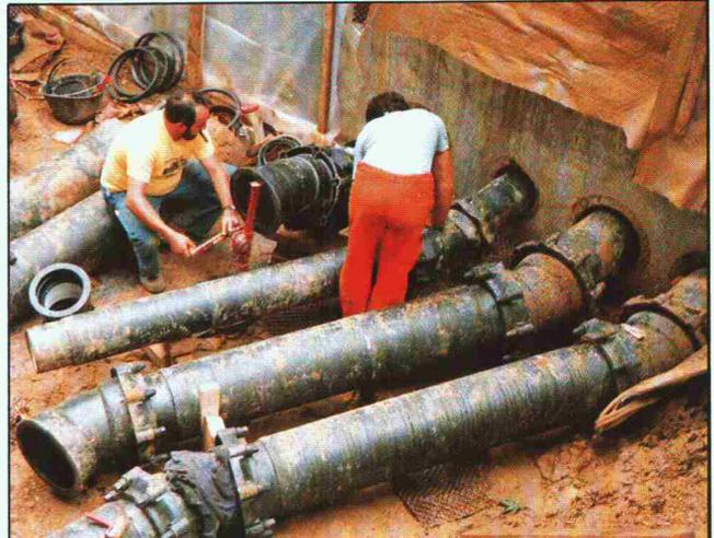
Alle vier auf einem Grossteil der Strecke nebeneinander liegenden Rohrleitungen wurden nach System TIS/TIS-K schubgesichert. Die Vorteile dieses Systems liegen einerseits bei dessen sehr hoher Zugfestigkeit und andererseits bei der Tatsache, dass Rohre und Formstücke auch in schubgesichertem Zustand um bis zu 3 Grad je Muffe abgewinkelt werden können. Schwierige Konstruktionen, wie hier bei der Einführung der Rohrleitungen ins Reservoir, sind deshalb praktisch überall problemlos möglich.
