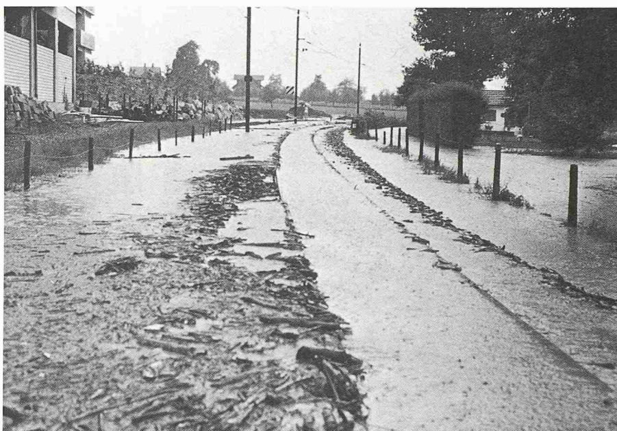
Bild 3. Das überschwemmte Trasse der Brünigbahn nach dem schweren Unwetter von 1984 in Sachseln
