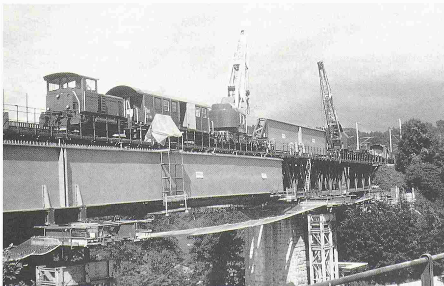
Bild 6. Montagephase der Stahlträger: Bereitgestelltes Trägerpaar, begleitet von zwei Bahnkrangruppen für den Ablad und das seitliche Versetzen neben die alte Brücke
