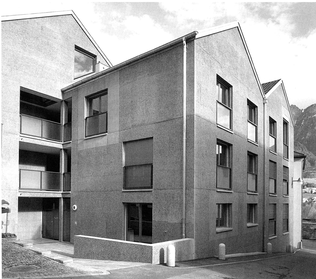
Strassenfassade mit zwei Giebeln, Vorplatz und Eingang. Ansicht von Westen.
