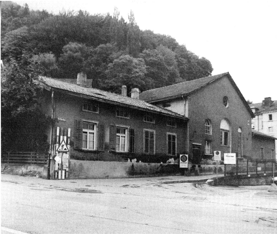
Das Hauptgebäude des ersten Churer Gaswerks. Die nach Westen, zum Hofgraben hin gerichtete Hauptfassade ist repräsentativ gestaltet. Bild aus einer Fotodokumentation des Gaswerkareals von 1995, erstellt anlässlich des damals geplanten Abbruchs des Gaswerk-Nebenhauses (StadtAC F 05.037).
