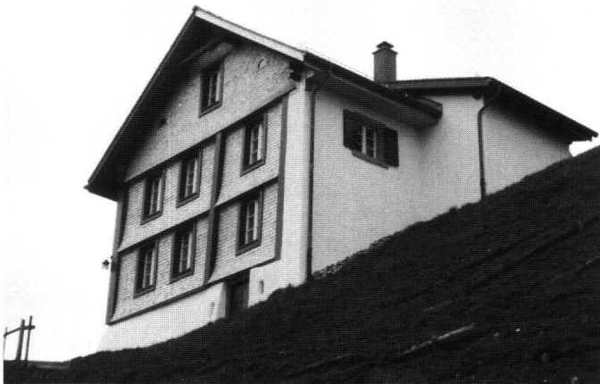
Abb. 5: Altendorf, Sigristenhaus St. Johann. Im 19. Jahrhundert wurde das Gebäude, das in seinem Kern ins 16. Jahrhundert zurückreicht, vollständig umgebaut. Der Zustand des 19. Jahrhunderts wurde bei der Sanierung beibehalten.
