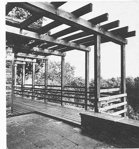
Bilder 56-59. Anbau einer Loggia in der Casa Nascosta in Ascona (1977). Ein bestehender Steinbau wurde ausgekernert und mit einer grossen Veranda erweitert
