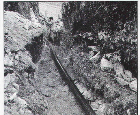
10.45 Die erste Länge ist verlegt...
