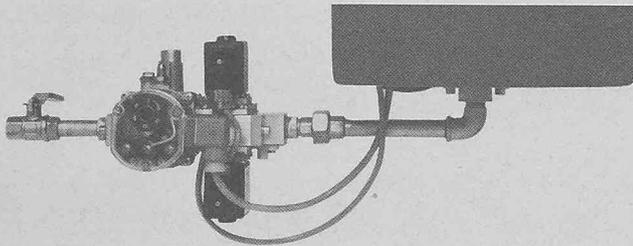
einem äusserst kompakt gebauten Gasgebläsebrenner. Die Gebläsetechnik wurde bewusst auch für diesen Kleinstleistungsbereich angewendet, weil zusammen mit einem modernen Heizkessel ein Optimum an Wirtschaftlichkeit erzielt werden kann.
