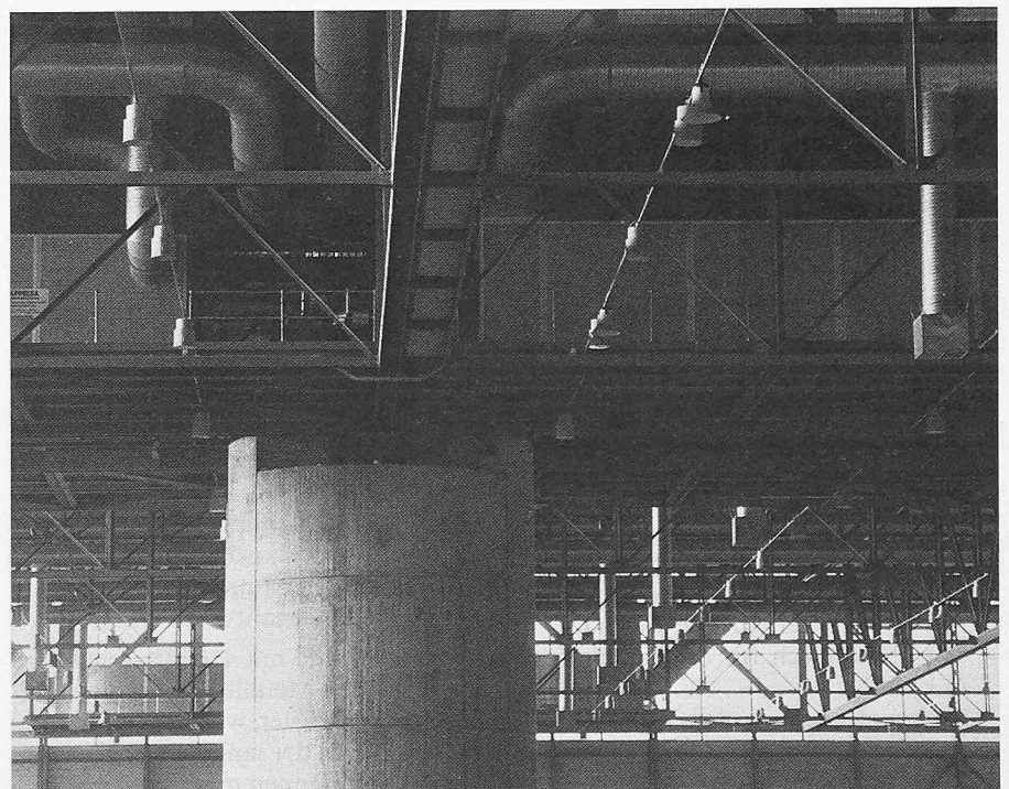
Fertige Stahlkonstruktion im Bereich eines Auflagerturms
