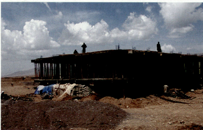
Häuserbau in der Provinz Loghar.
