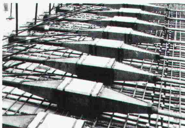
Vorfabrizierter Träger mit beweglicher Verankerung Typ A 2350
