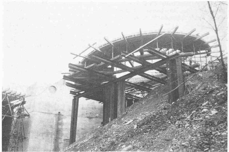
Bild 9. Einrüstung einer Spiralrampe
