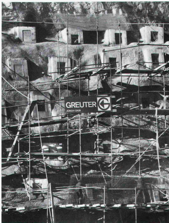
Felssicherung Dangernfluh, N2 (Eptingen)
