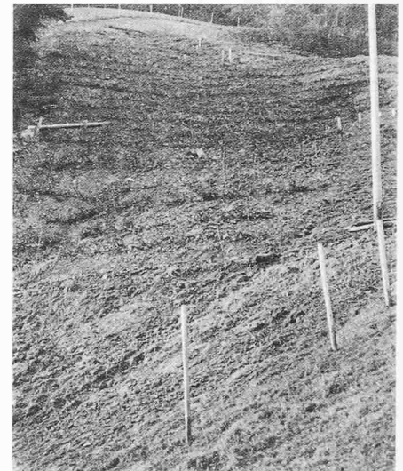
Bild 10. Schlupf, mit Buschlagen verbaut und dazwischen aufgeforstet. (kombinierte Bauweise)
