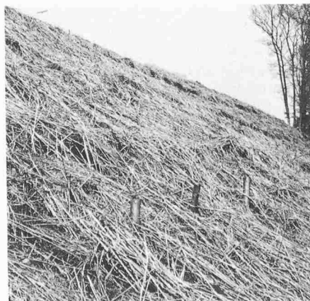
Bild 15. Kerzers N1, Mühle Grau. Die geschüttete Kiesböschung wurde mit Stechkölzern vernagelt, hinter welche Weidenstämme gerollt wurden; die Fläche wurde mit Schilf abgedeckt. (Stabilbauweise)
