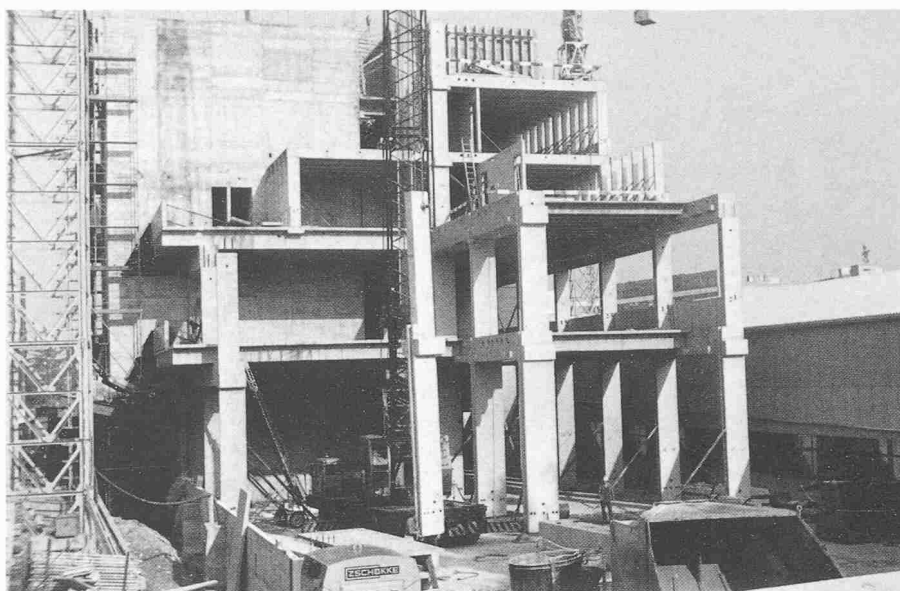
Montage des östlichen Traktes. Auch die Zwischenwände mit den Türzargen sind vorfabriziert
