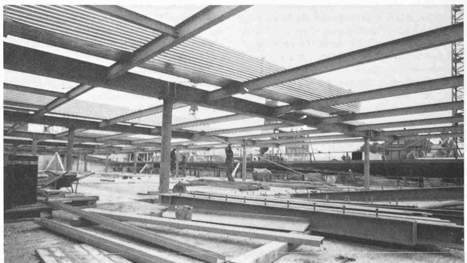
Vollstahlstützen, Haupt- und Sekundärträger, Verbundbleche zum Verlegen bereit
