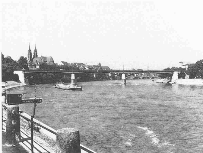
Bild 1. Ansicht der Wettsteinbrücke
