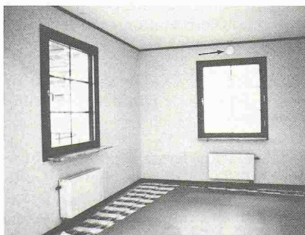
Bild 10. Regulierbare Zuluftöffnungen
