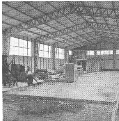
Die neue Fabrikhalle der Int. Verbandstoff-Fabrik Neuhausen a. Rheinfluss
