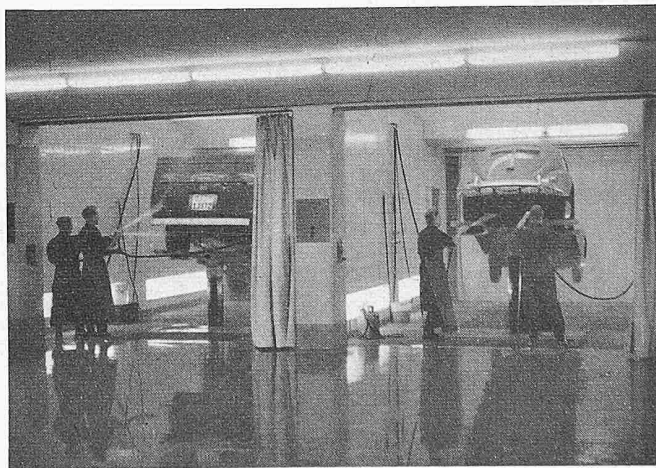
Bild 12. Zwei von den drei Waschplätzen mit speziellen Säulenliften und mit weitem Licht- und Luftschacht durch das Erdgeschoss bis auf Dachhöhe
