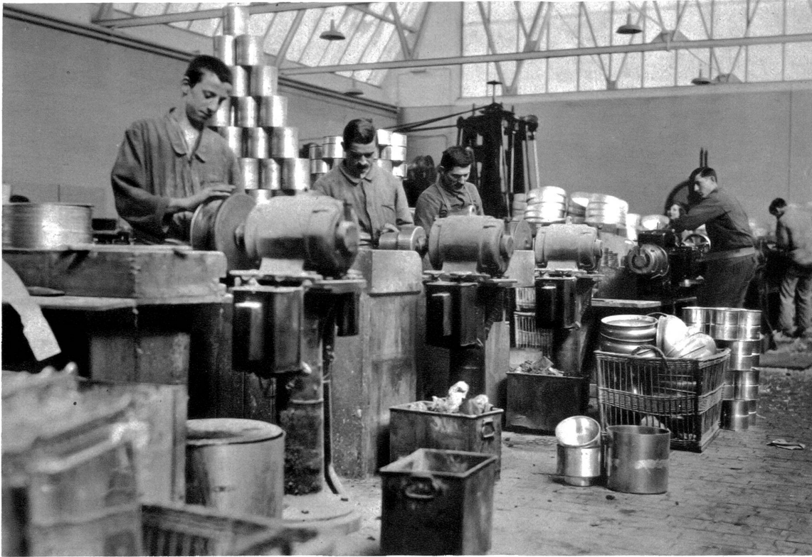
In der Schleiferei. Die egalisierten Hohlgefäße werden auf Spezial-Schleif- maschinen innen fein geschliffen.
