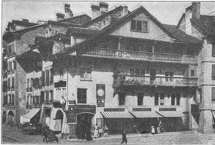
Abb. 11. Ansicht der Häuser 2, 4 und 4a an der Spitalgasse, Ecke Waisenhausplatz. Haus Nr. 2 stammt aus dem Anfang des XVI. Jahrhunderts.
