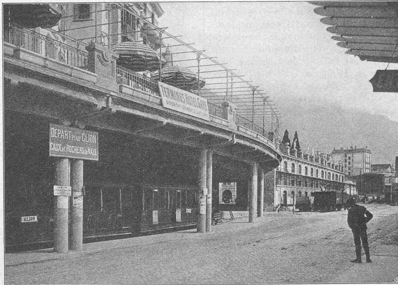
Abb 10. Eisenbetonterrasse im Bahnhof Montreux; Durchblick nach dem Tunnel Nr. 2.
