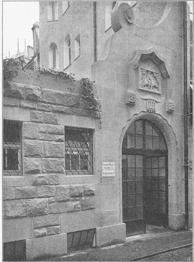
Abb. 8. Einfahrtstor an der Augustinergasse.
