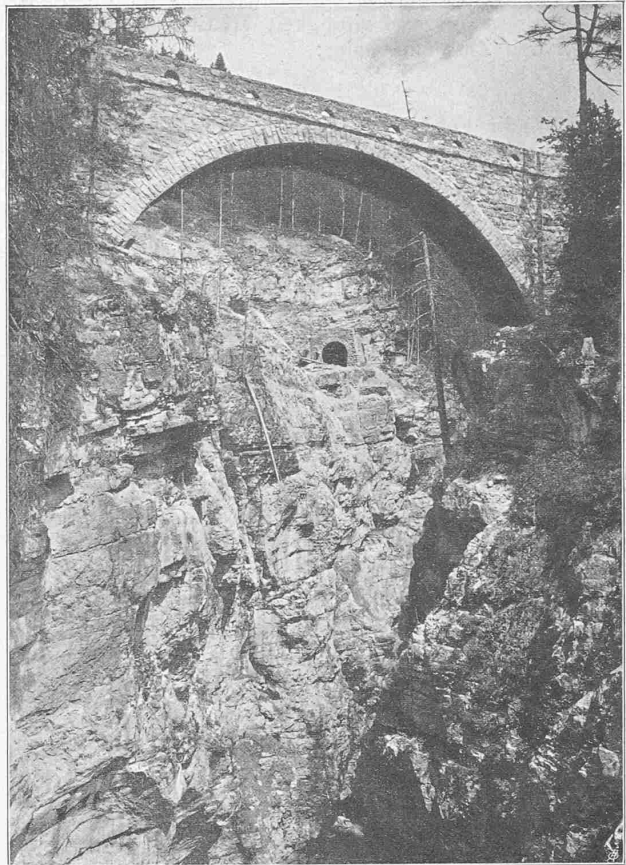
Abb. 19. Gewölbte Brücke der Zufahrtsstrasse nach Jennisberg und unteres Portal des Wiesener Tunnels II.
