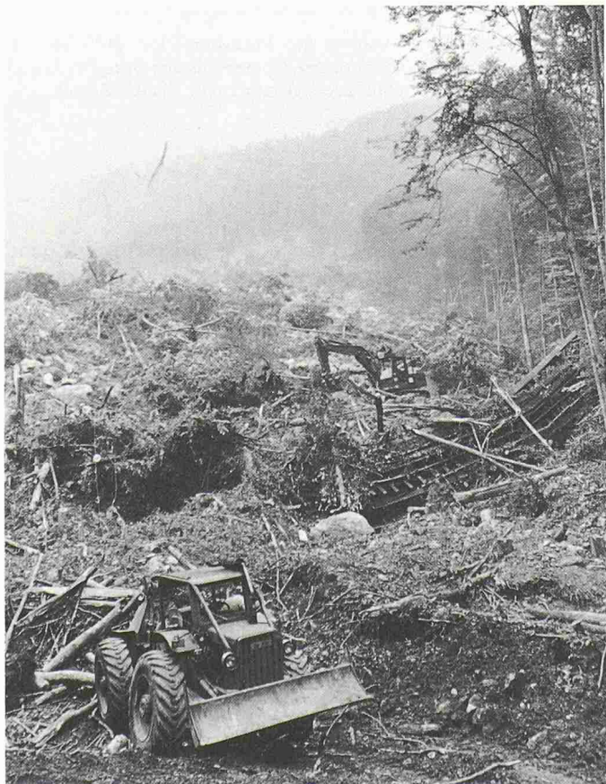
Bild 3. Rutschmasse im unteren Teil, rechts erkennbar die Sahl-fachwerkbrücke der SBB. (Foto: J. Reinhard, Sachseln)
