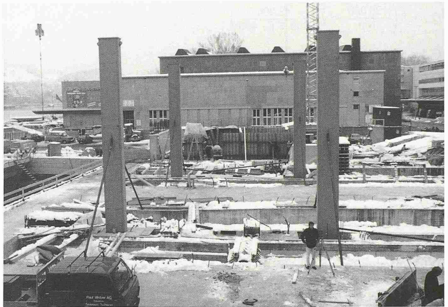
Bild 2. Montage der Hochbaustützen in den Gleiswannen, noch ohne Knautschzone
