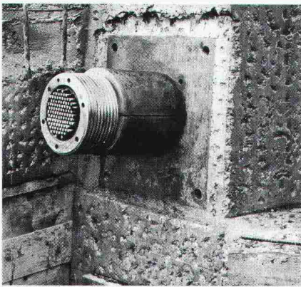
Brückenträger mit beweglicher Verankerung Typ M 4600
